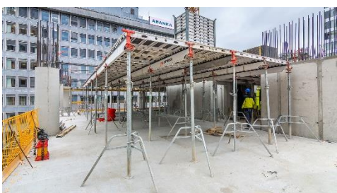
Slika 8: SKYDECK panelni stropni opaž. (slika: PERI oplate i skele, d. o. o.)
