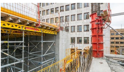
Slika 9: Okrogli stebri različnih premerov ( \varnothing 90 , \varnothing 80 , \varnothing 70 in \varnothing 60 ) so izvedeni s SRS krožnim jeklenim opažem. (slika: PERI oplate i skele, d. o. o.)
