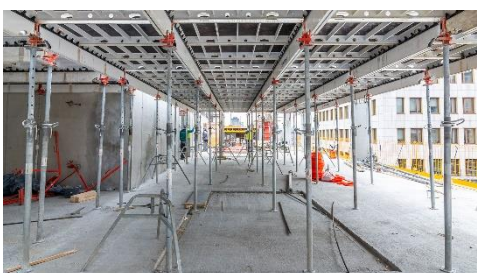
Slika 7: SKYDECK panelni stropni opaž za izvedbo osrednjega dela etažnih plošč. (slika: PERI oplate i skele, d. o. o.)
