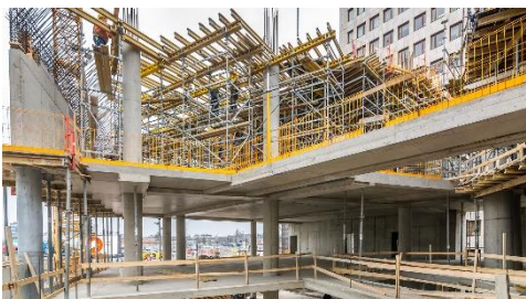
Slika 11: Poševna stropna plošča 3. etaže s PERI UP Flex podpiranjem in PROKIT ograjo na robu plošče. (slika: PERI oplate i skele, d. o. o.)
