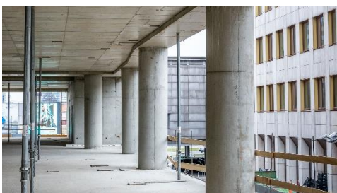
Slika 10: Okrogli stebri izvedeni s SRS krožnim jeklenim opažem. (slika: PERI oplate i skele, d. o. o.)
