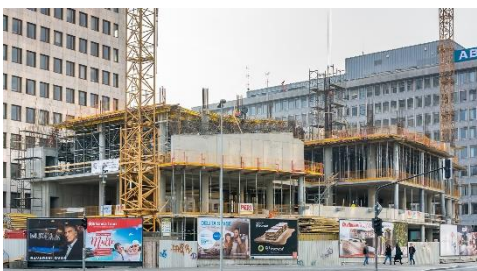
Slika 5: Za povečano razliko svetle višine etaže PERI je dobavil daljše PEP podpornike za stropni opaž.
