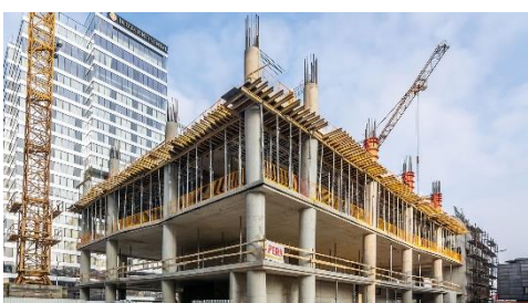
Slika 4: Po dokončanju podzemnih etaž se vsa oprema nadalje uporablja za izvedbo pritličja in etaž od 1. do 3.
