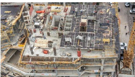
Slika 15: Na tipičnih etažah od 4. do 22. nadstropja se uporablja TRIO stenski panelni opaž za izvedbo sten jedra objekta in SKYDECK stropni panelni opaž za osrednji del etažnih plošč. (slika: PERI oplate i skele, d. o. o.)
