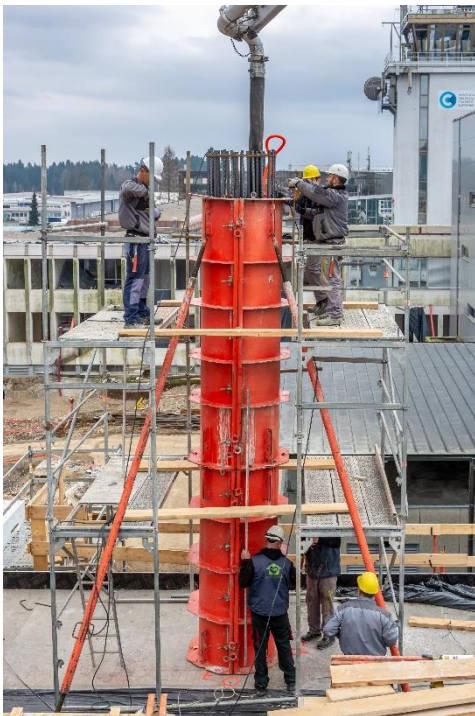
Slika 10: SRS jekleni okrogli opaž za izvedbo okroglih stebrov z vrhunskim odtisom vidnega betona. (slika: PERI oplate i skele, d. o. o.)
