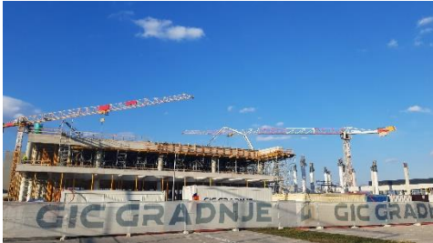
Slika 1: Izvedba nosilcev in armiranobetonske plošče prve etaže nove terminalske zgradbe. (slika: GIC GRADNJE, d. o. o.)
