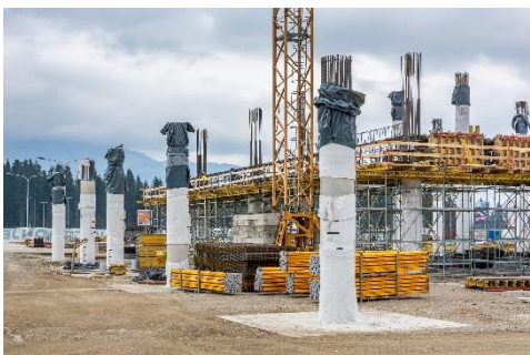
Slika 16: MULTIPROP podporniki so pripravljeni za naknadno podpiranje izvedenih nosilcev in plošč. (slika: PERI oplate i skele, d. o. o.)
