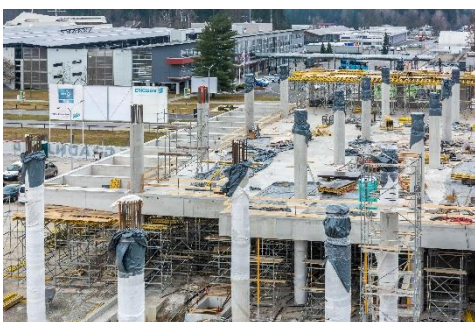
Slika 4: Okrogli stebri višine 5,5 m in 11,0 m premerov \varnothing 90 in \varnothing 70 izvedeni s SRS jeklenim okroglim opažem. (slika: PERI oplata i skele, d. o. o.)
