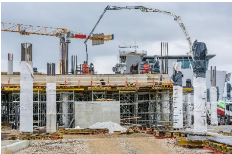
Slika 15: Izvedba sten, temeljev in jaškov z DUO lahkim panelnim opažem. (slika: PERI oplate i skele, d. o. o.)
