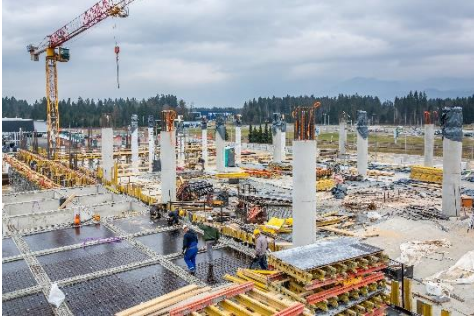
Slika 12: Okrogli stebri izvedeni s SRS jeklenim okroglim opažem. (slika: PERI oplate i skele, d. o. o.)
