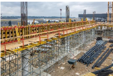
Slika 8: Izvedba nosilcev s podpiranjem s PERI UP Flex modularnimi nosilnimi stolpi. (slika: PERI oplate i skele, d. o. o.)
