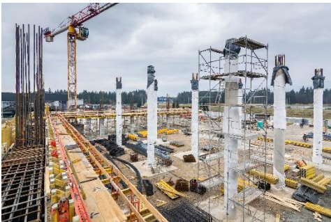
Slika 7: Okrogli stebri višine 11,0 m izvedeni s SRS jeklenim okroglim opažem. (slika: PERI oplate i skele, d. o. o.)
