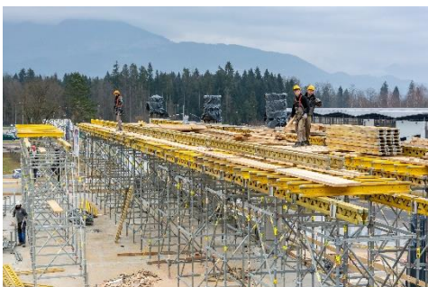
Slika 11: PERI UP Flex modularni podporni stolpi, kot nosilna podporna konstrukcija MULTIFLEX stropnega opaža z lesenimi nosilci. (slika: PERI oplate i skele, d. o. o.)
