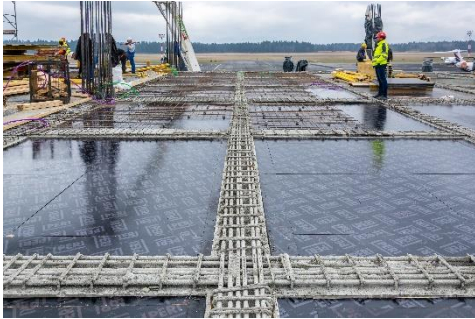
Slika 9: Izvedba armiranometonskih plošč z opažnimi ploščami FinPly za vrhunski odtis vidnega betona. (slika: PERI oplate i skele, d. o. o.)
