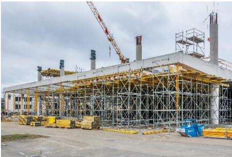
Slika 13: Podpiranje konzolnih nosilcev na vhodno-izhodnem delu terminala. (slika: PERI oplate i skele, d. o. o.)
