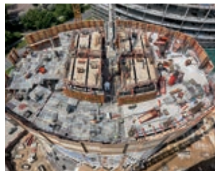
Območje eliptične plošče s standardnimi komponentami
