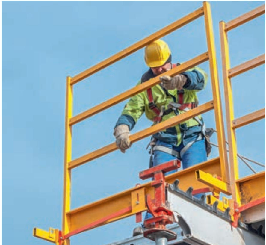
Stranska zaščita na cikličnih spojih v tlorisu
