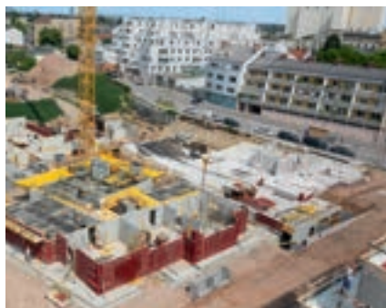
Sistema SKYDECK in MAXIMO sta določila hiter tempo
