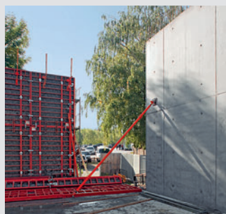
Uređeni raster fuga i sidara na vidnim zidnim površinama. Poslovna zgrada Outlet-Center, Metzingen
