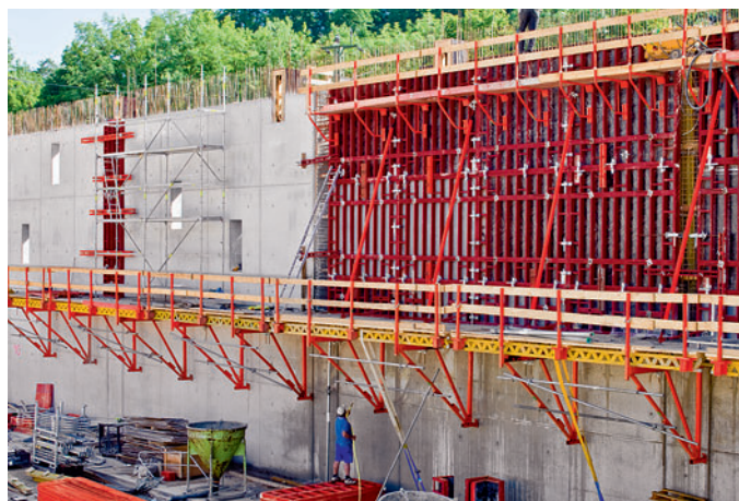
Uredna slika fuga i sidara dopušta betonske površine visoke kvalitete. Garaža Albanstraße, Mainz
