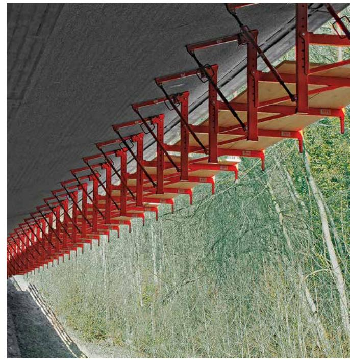
Konzola za oplatu vijenca VGK konstruirana je i za horizontalne i vertikalne primjene. Konzole se mogu učvršćivati jednostavnim postavljanjem svornjaka na ovjesnu glavu i na donju stranu konzole te na zidove ležišta.
