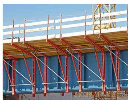
Ukruta konzolnih jedinica komercijalnim konzolnim cijevima Ø 48 mm.
