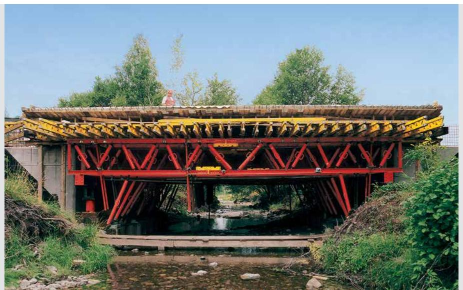
Rješenja iz najma u mostogradnji. Nosači rešetkaste konstrukcije od SRU čeličnih profila i SLS vretena kao dijagonala.
