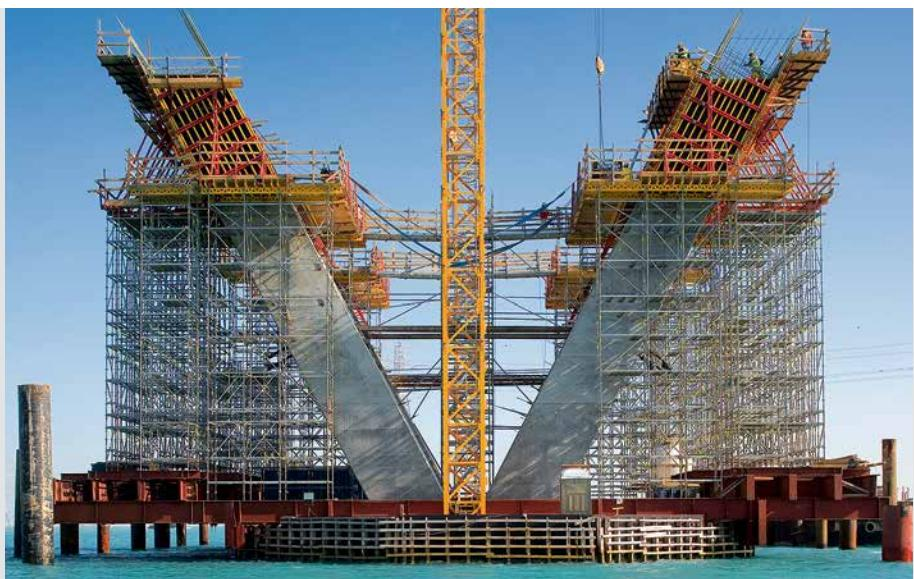
Varijalne ploče rešetkaste konstrukcije za izvođenje opterećenja svježeg betona i kao privremeno podupiranje objekta.
