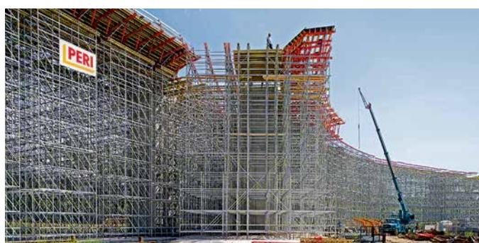
Predmontirane jedinice oplate na nosačima responske konstrukcije velikih raspona.
