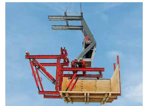
Geometrija glave ovjesa omogućuje brzo bočno spuštanje i okomito automatsko centriranje jedinice na kotačima.
