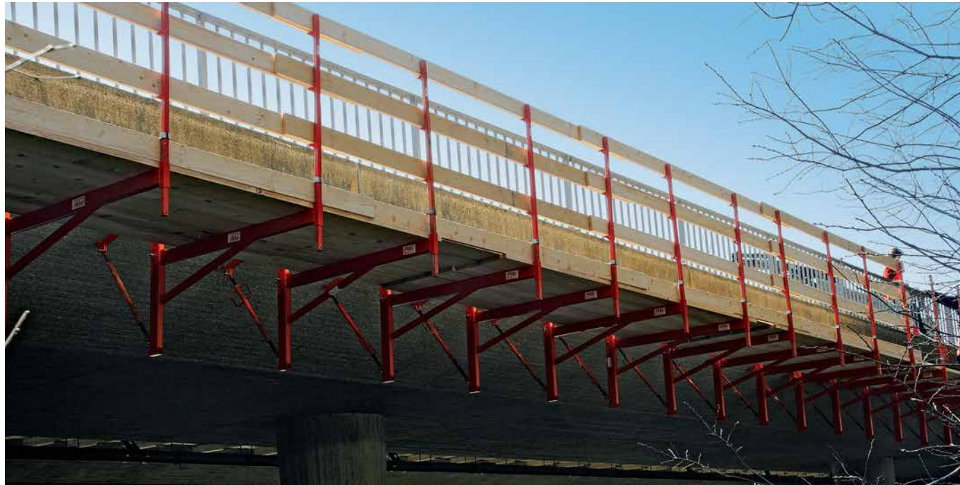
**Lagana PERI konzola za oplatu vijenca VGK, koja se može montirati rukom, upotpunjuje paletu rješenja s oplatom vijenca. Za kratke gornje konstrukcije mosta kod novogradnje te kod sanacija konzola oplate vijenca VGK predstavlja racionalno i povoljno rješenje.**
