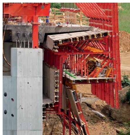
Prolazak stupa bez problema je moguć nakon hidrauličkog spuštanja radnog podesta i oplate tla.
