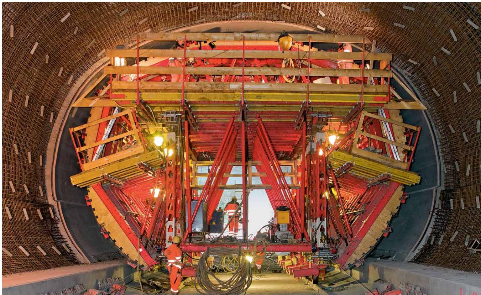
**Kolica za montažu za rudarski tunel općenito moraju ispunjavati vrlo visoke zahtjeve u pogledu normiraniosti i pritiska svježeg betona.**
