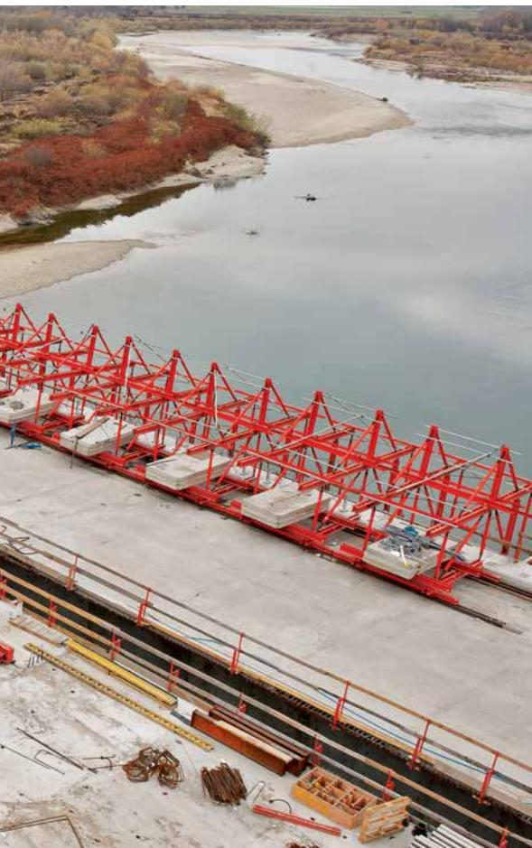
PERI VARIOKIT krletka sastoji se od novih glavnih okvira koji omogućuju izjednačavanje uzdužnog i poprečnog nagiba mosta bez ispune drvenim gredicama.
