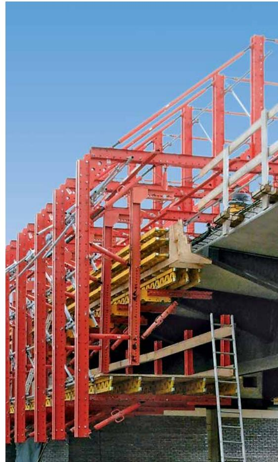
Konzolni istaci, mjesa spoticanja na poprečnim profilima u području konzola i ograničeni slobodni profili odlučujući su kriteriji za PERI VARIOKIT kolica za oplatu vijenca.
