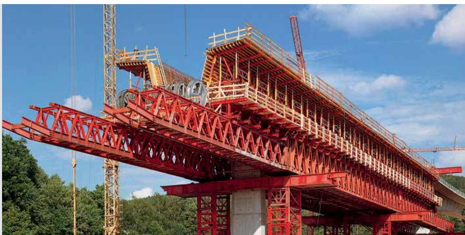
I rasponske konstrukcije za taktno naguravanje s donje strane mogu se nadopunjavati sistemskim oplatama te time ekonomično primjenjivati. Za premeštanje se najprije skela i oplata pomiču bočno, zatim u uzdužnom smjeru te onda ponovno poravnavaju.
