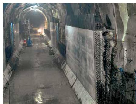
Najbolji rezultati betoniranja iz 2. takta (poredručje zida) čine izlaz za kolica za montažu luka.
