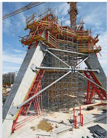
Iste sistemske komponente za privremeno podupiranje objekta te za primjenu penjače skele.
