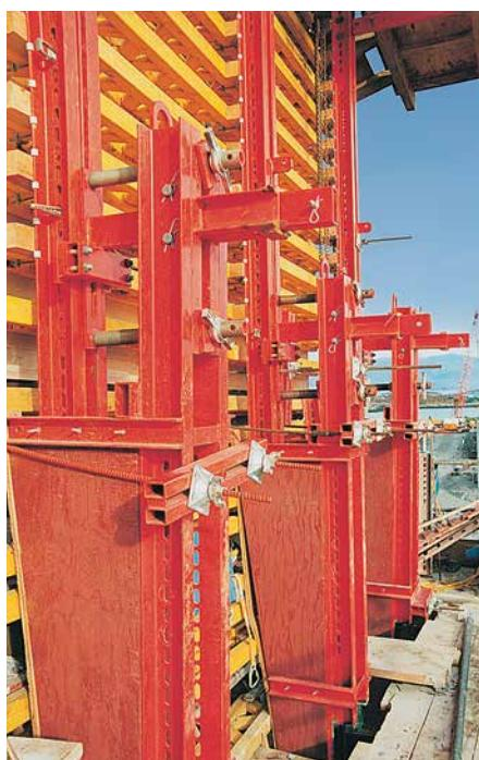
Izmjene vanjske geometrije rebara zahtijevaju varijabilne konstrukcije. VARIOKIT čelični profili i vretena ovdje nude kontinuirane i sigurno nosive sisteme.
