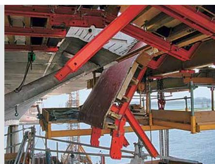
Geometrijski komplikirani detalji u području konzole fleksibilno se montiraju VARIOKIT modularnim sistemom. Oplata se pomicaju laganim uređajem za lančano povlačenje.
