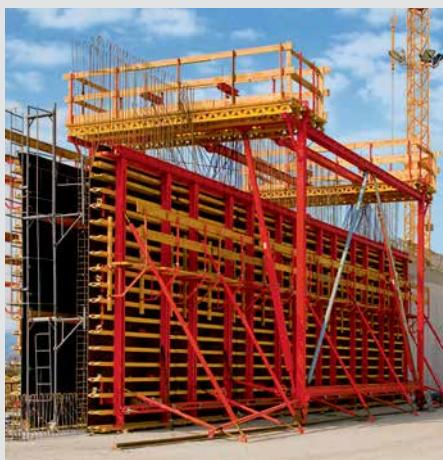
Jasno su vidljiva 2 zasebna takta betoniranja, slijeva zid i zdesna strop. Obje oplate izvedene su kao pomicne jedinice.
