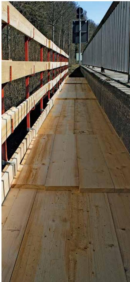
Odvajanjem prihvata oplate i obloge podesta nije potrebna preinaka obloge podesta nakon uklanjanje za betoniranje. Prihvat oplate jednostavno se postavi na oblogu podesta.
