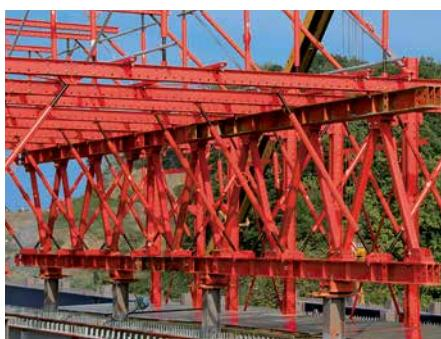
Ekstremno ukrućeni uzdužni nosač rešetkaste konstrukcije omogućuje optimalnu raspodjelu opterećenja i štiti nosače mosta od točkastog preopterećenja.
