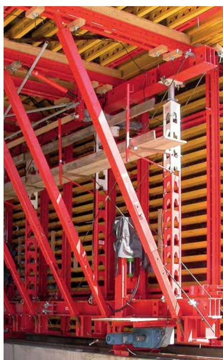
Dijagonalni profil ugrađuje se pomoću standardnih spojnica u stropnom nosaču. Standardan raster otvora u svim sistemskim komponentama nudi brojne mogućnosti priključivanja.
