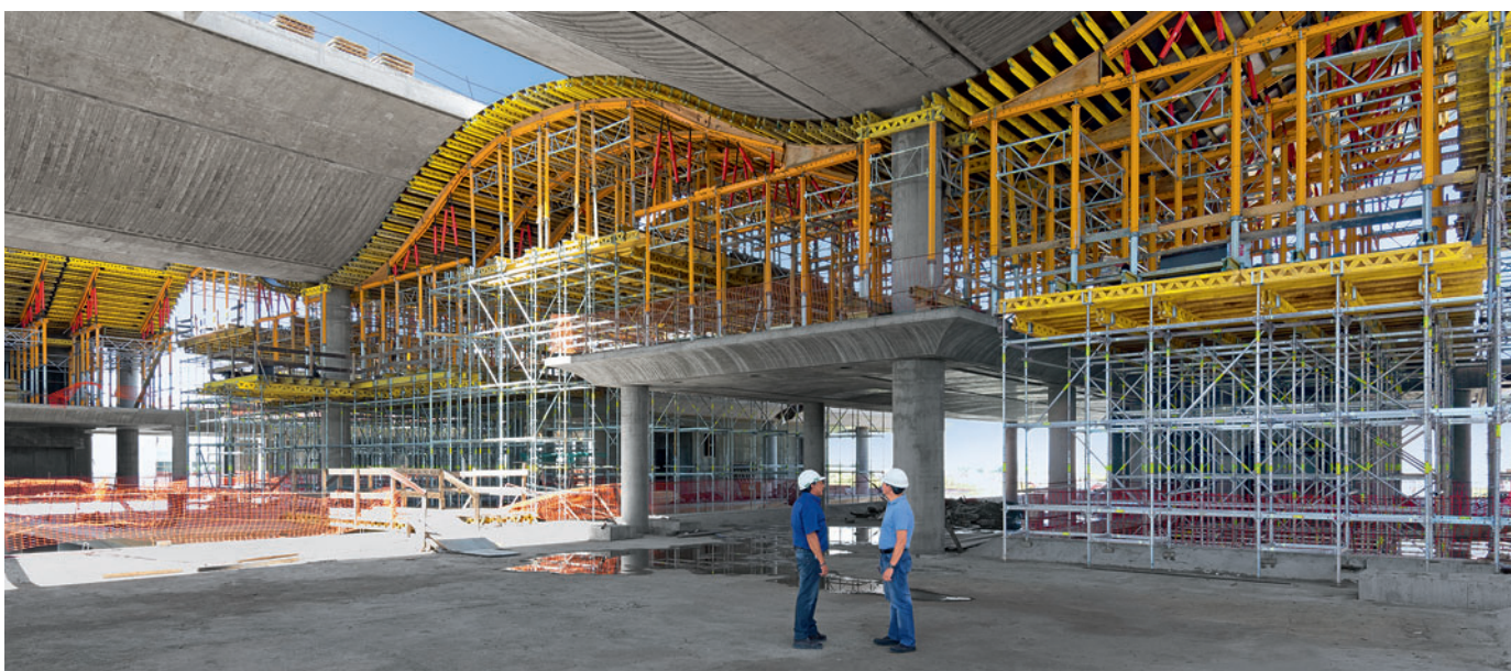
Primjenom drvenih remenata i predmontirane VARIOKIT konstrukcije ovi stropni stolovi precizno se prilagođuju valovitoj stropnoj konstrukciji.
