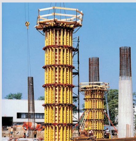
PERI GRV i nosač oplata GT 24 u primjeni kod konične oplata stupa.
