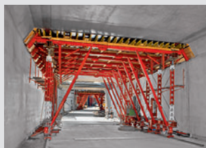
Oplaste za tunele
