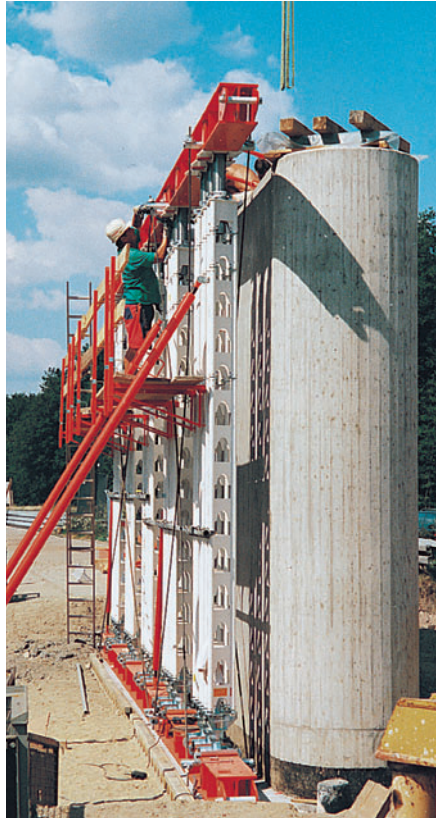
Konzola 75 HD za 75 cm široku radnu skelu. Maks. razmak: 1,25 m. Dop.opterećenje: 150 kg/m 2
