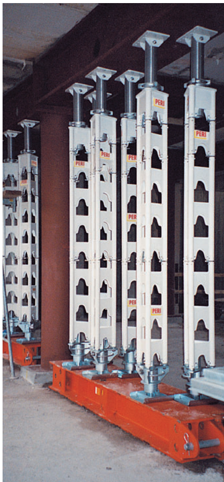
60 lfdm nadogradnja kolnika na HD 200.
