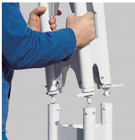
Postaviti 2. segment za podupiranje ...
