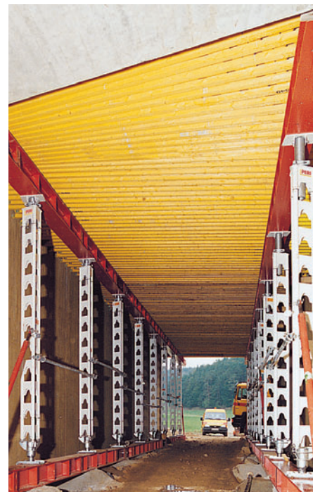
60 lfdm nadogradnja kolnika na HD 200.
