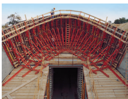
Portal tunela u obliku elipse s RUNDFLEX elementima i priborom iz VARIO programa. Pomoću konično izrezanih prilagodnih gredica riješen je problem konstantno izmjenjivih polumjera i nagiba.
