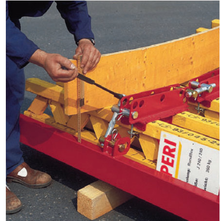
Vretenom 210 za podešavanje rubnog profila rukuje se pomoću kombi ključa za montažu.
