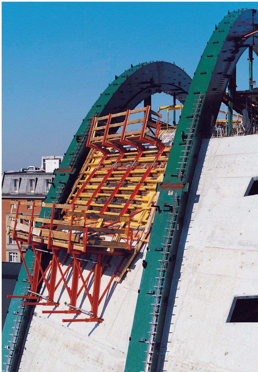
RUNDFLEX primijenjen "polešce" prilikom gradnje betonskog svoda Kulturnog centra u Berlinu.
