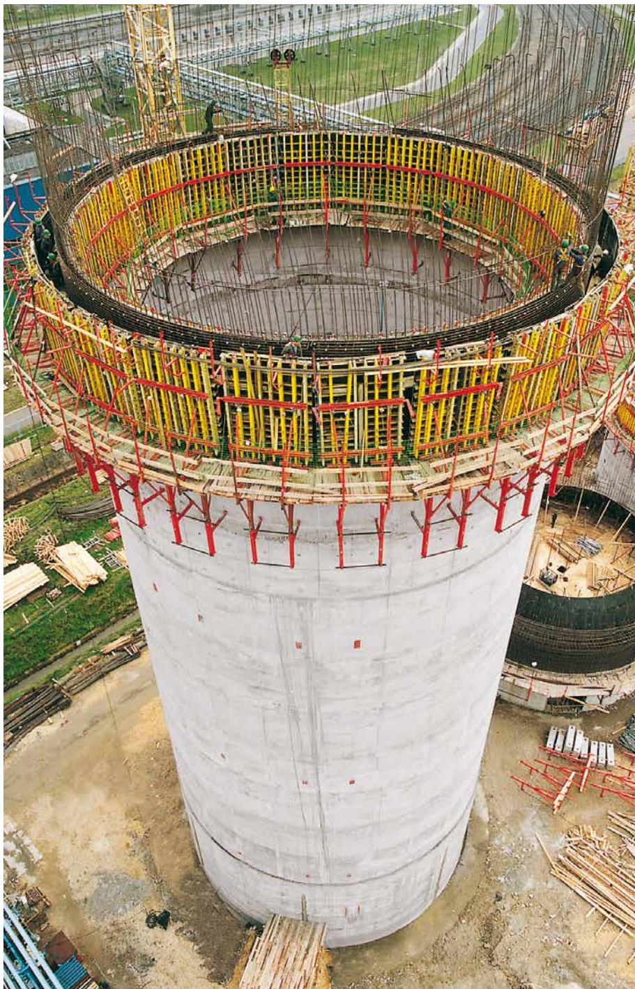
Silos, h = 72 m, Ø = 20 m na elektrani u Oppelnu u Poljskoj. Montaža kružnom VARIO opatom s nosačima na penjajućoj skeli KGF.
