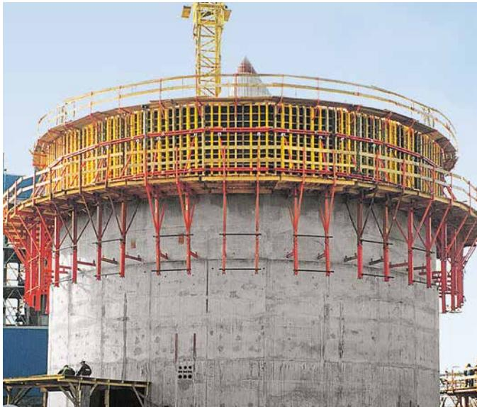
VARIO GT 24 prilikom gradnje kružnog spremnika. Drveni klinovi između nosača i čeličnog profila omogućuju kružni oblik.
