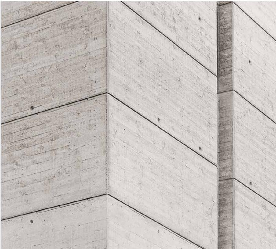
Bespriječoran vidni beton s grubom horizontalnom daščanom struktururom.
