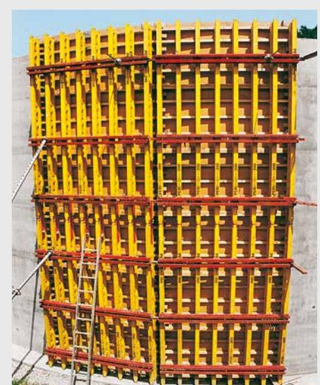
Kružna oplata visine 7,50 m s remenatama na GT 24 nosačima.
