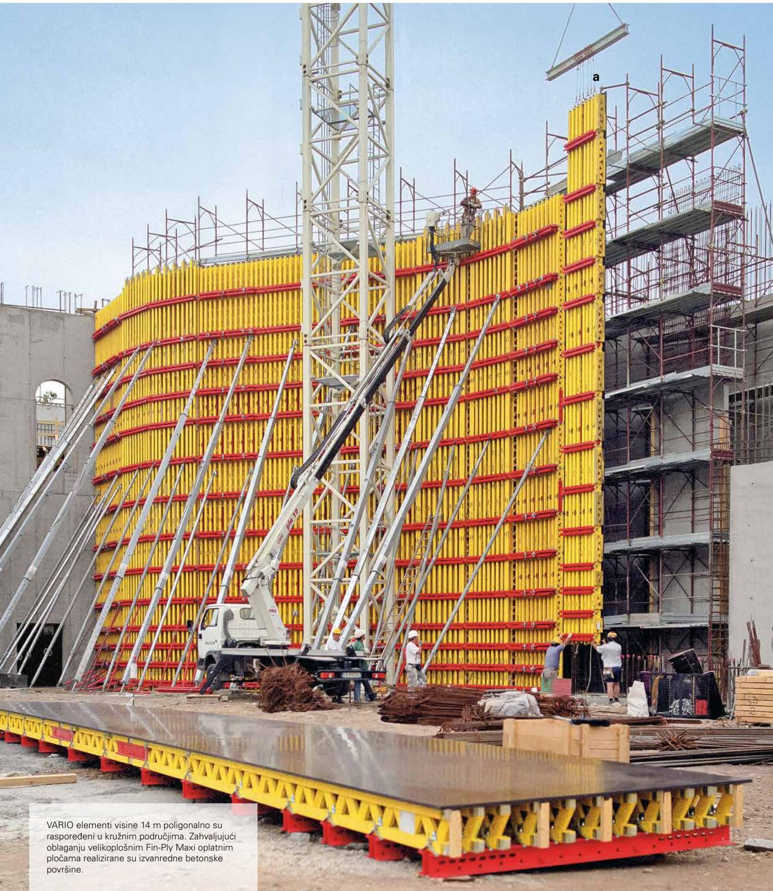
VARIO elementi visine 14 m poligonalno su raspoređeni u kružnim područjima. Zahvaljujući oblaganju velikoplošnim Fin-Ply Maxi oplatnim pločama realizirane su izvanredne betonske površine.
