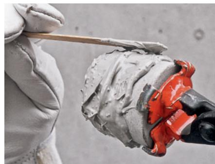
Betonski konus staviti u otisak i više ga puta okrenuti kako bi se dvokomponentno ljepilo ravnomjerno razmazalo.
