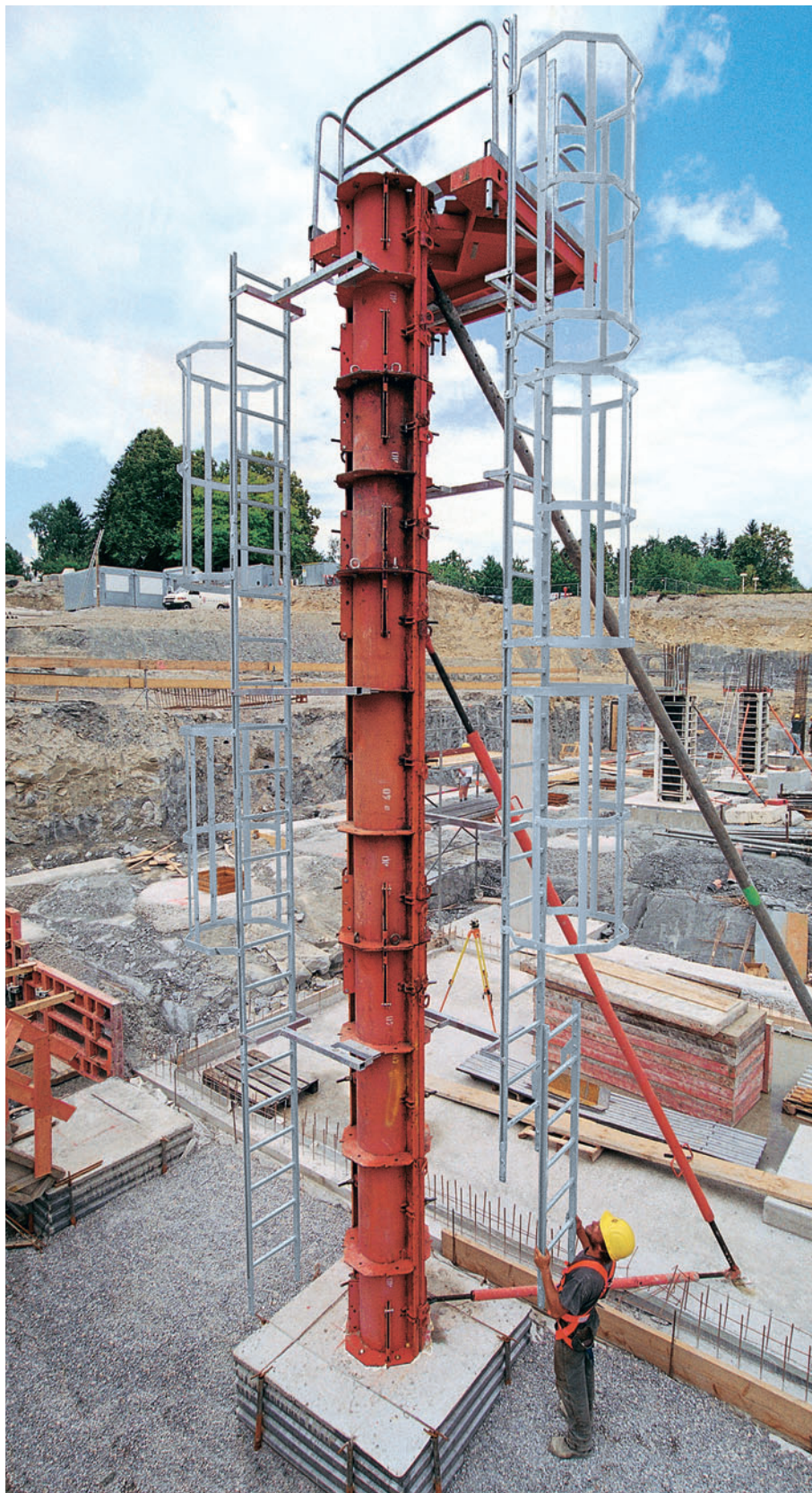
Sigurni radovi na podestu za betoniranje na svakoj visini.
